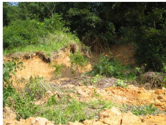
写真-6 崩壊地 2 の土砂体積状況
