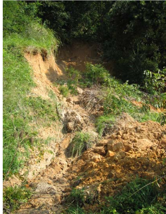
写真-5 虎仙窯の崩壊地 2
