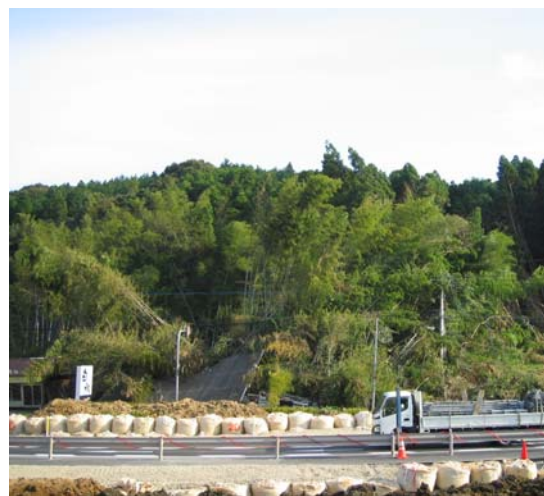
写真-2 地すべり脚部および仮設道路の様子（9月28日撮影）
