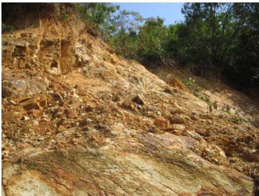
写真-4 崩壊地 1 の滑落崖
